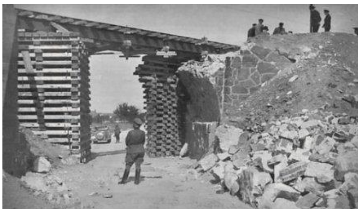
Reparatur einer zerstörten Eisenbahnbrücke, Chojnice 1939
